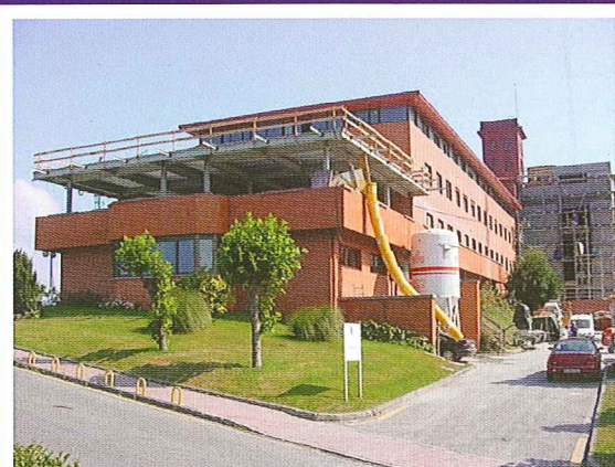
PAC, Ensayos de control, revisión de proyecto, estructura e instalaciones. Supervisión, ensayos y pruebas de las instalaciones de la obra de Reforma y Ampliación del Hospital de Jove (Gijón).
