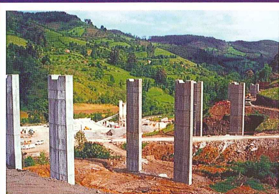
PAC Integral de Obra: Autovía del Cantábrico (Lieres - Villaviciosa) Viaducto de Cabañón
