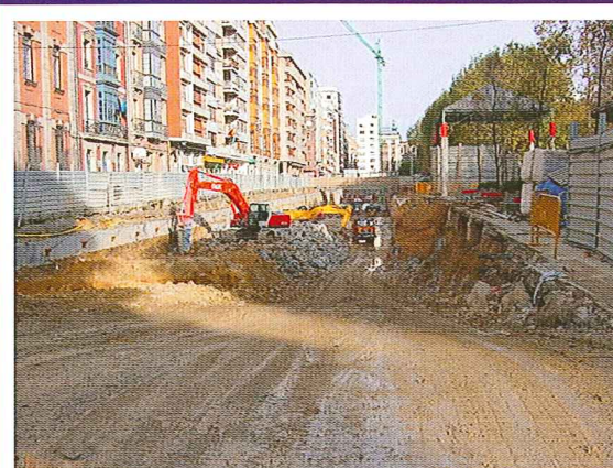
Control de calidad. Parking subterráneo de Begoña (Gijón).
