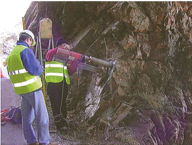
Perforadora Hilti. Toma de muestras en un túnel (Carretera AS-17 - Tarna)
